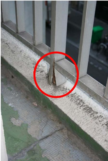
Décollement et oxydation des fixations des garde-corps
