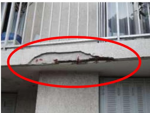
Eclatement du béton dû à la poussée du fer à béton
