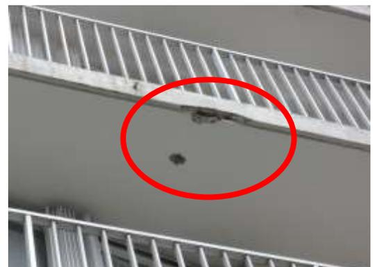
Eclatement du béton dû à la poussée du fer à béton
