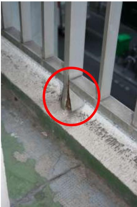
Décollement et oxydation des fixations des garde-corps
