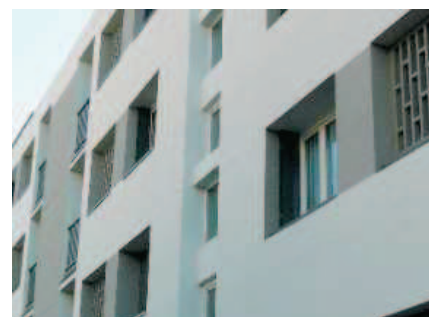
Exemple d'isolation sous enduit
