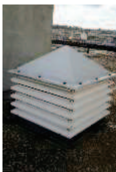
Lanterneau d'origine avant 2015
