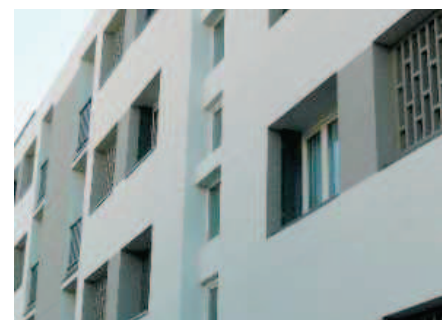
Exemple d'isolation sous enduit
