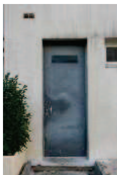
Porte d'accès parking
