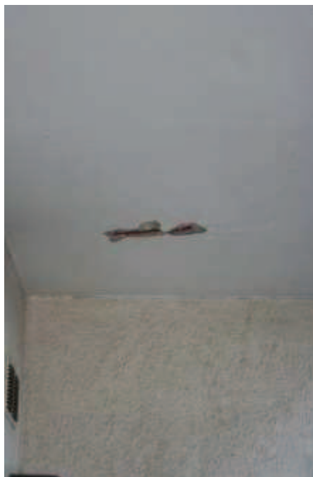
Epaufures au niveau des balcons
