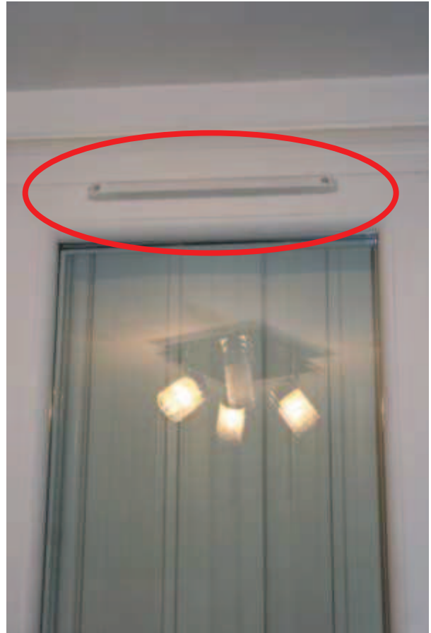
Présence de mortaises sur les menuiseries PVC double vitrage
