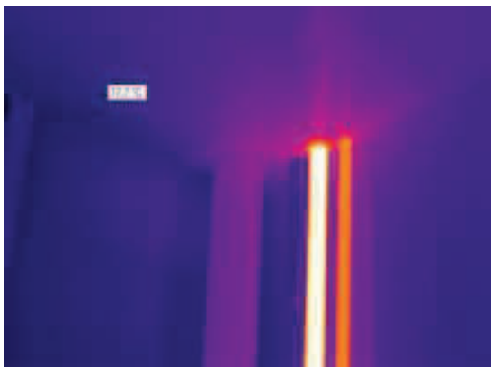
Colonne montante non isolée qui entraîne une déperdition
