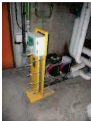
Echangeur à plaques et son compteur
