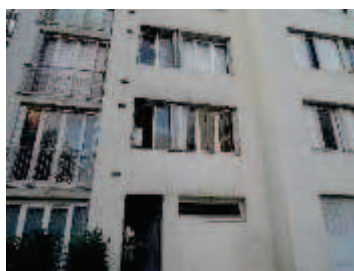
Façade cour remplissage parpaing
