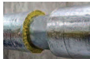
Calorifugeage laine minérale
